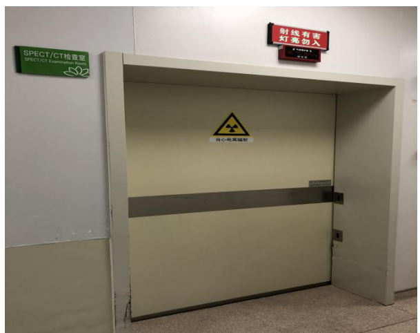
图 3-4 SPECT/CT 机房电离辐射警示标志
